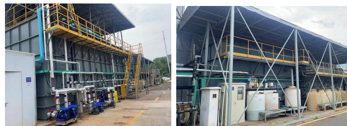
2025 年纽威阀门对原废水处理系统进行升级改造，增加 MBR 膜一体化设备，年可减少 COD 排放约 19.87t。
