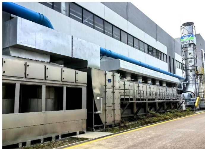
“气旋混动喷淋塔+干式过滤+活性炭吸附+浓缩催化燃烧技术 (RCO) 组合工艺”，通过催化燃烧将饱和的活性炭脱附再生，确保废气处理效率维持稳定，减少危废废活性炭产生。
