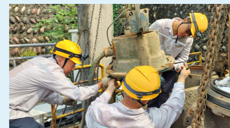
排水泵设备抢修
