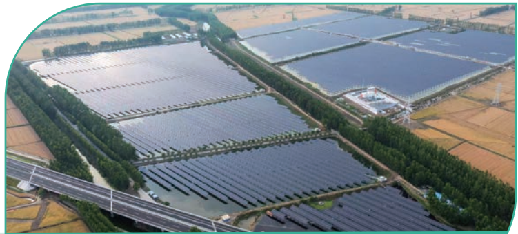
華能宿遷關廟100兆瓦漁光互補光伏發電項目
