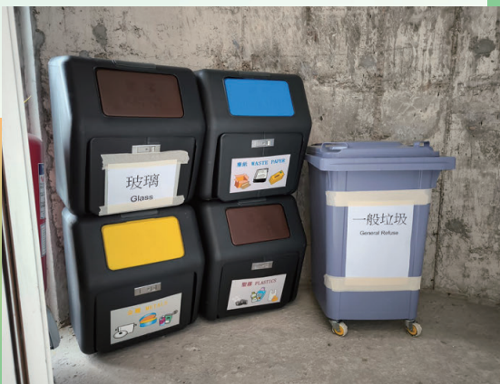
Recycling Station at the Construction Site 建築工地上的回收站
