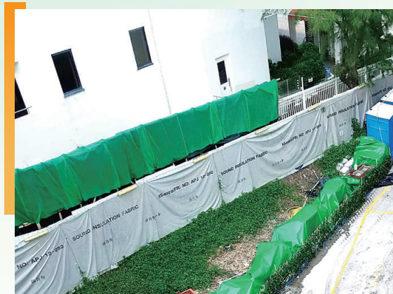
Noise Barriers Are Installed Onsite to Control Noise 在地盤使用隔音圍板控制噪音
