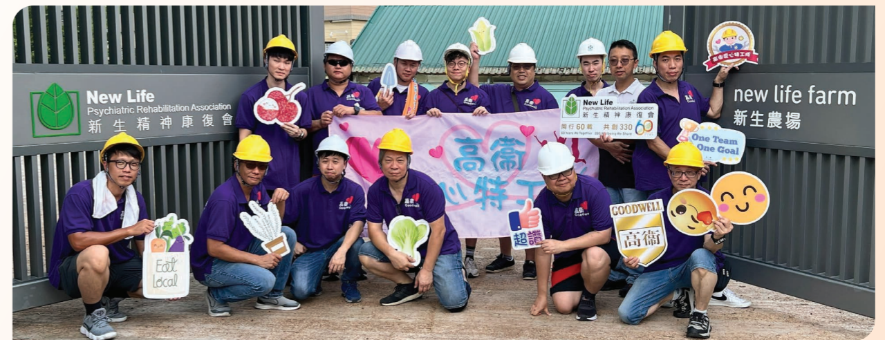
於2025年9月6日，高衛工程管理委員會義工發揮專業所長，為本港首個以社企模式營運的生態旅遊農莊「新生農場」進行室內活動室基本維修，並為室外鐵絲圍欄進行油漆工程。
