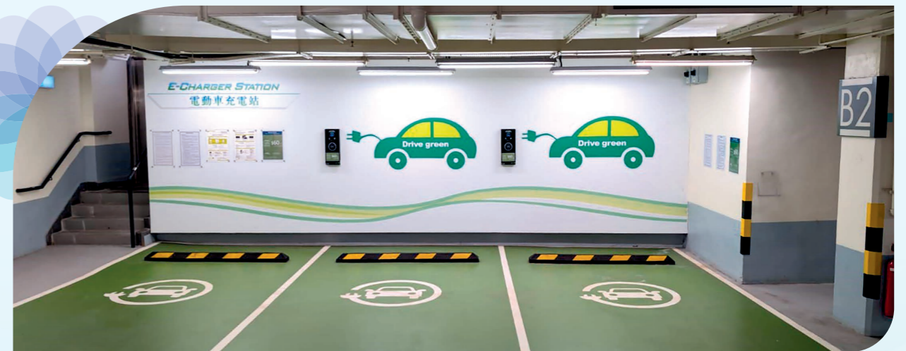
於長江集團中心的停車場安裝電動車充電設備，以推動可持續發展措施。
