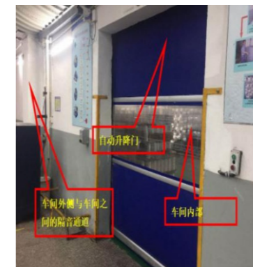
车间与外界采用隔音通道
