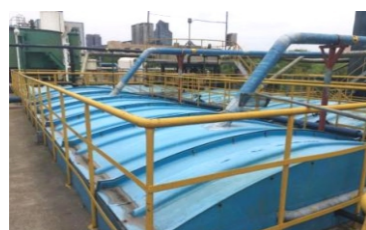
马桥化纤厂区污水处理站
