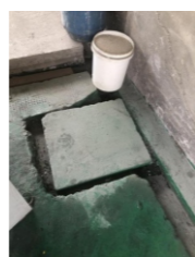
一般工业固废仓库渗出液收集池、应急防护设施及导流渠
