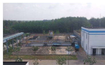
越南厂区污水处理站
