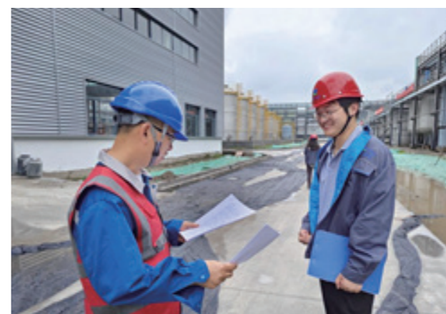
资源循环装备事业部开展“现场安全隐患有奖问答”
