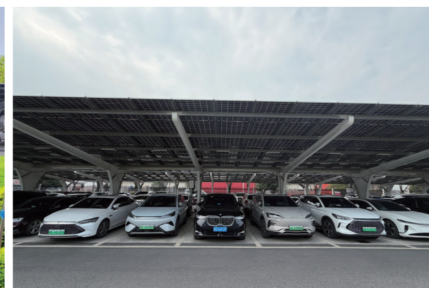
厂区新能源车辆充电桩
