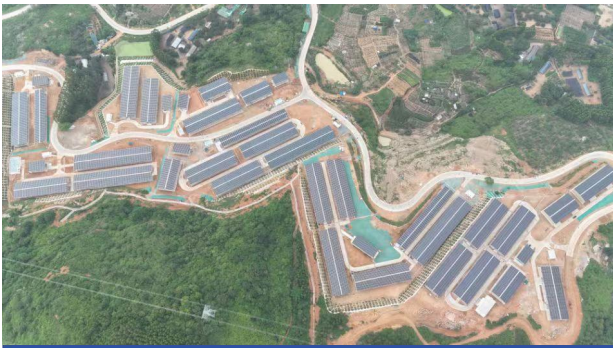
诏安县南方肉牛育肥场（一期）光伏项目
