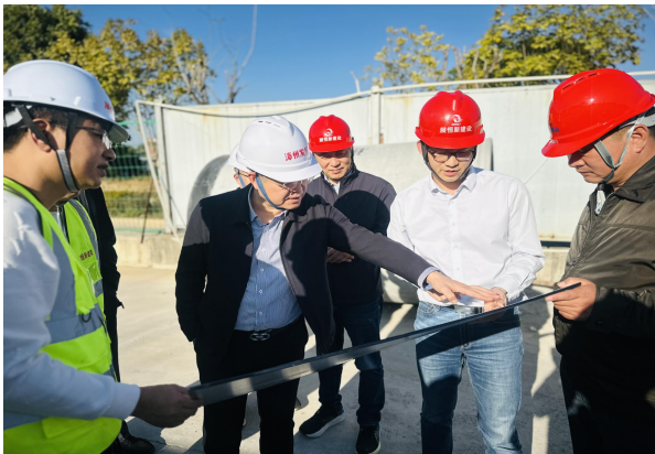
漳发建设项目施工现场安全督导检查
