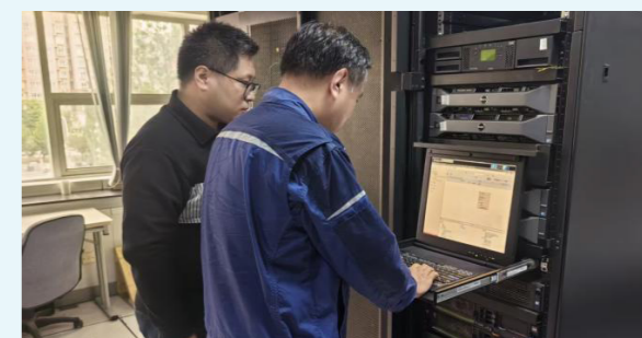
市电故障应急演练 ▶
