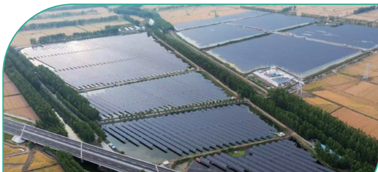
华能宿迁关庙100兆瓦渔光互补光伏发电项目
