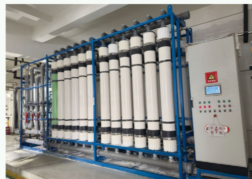
五矿信托 - 绿色投资 1 号项目现场
