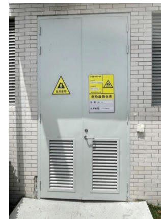
危险废物仓库（上海思源高压）
