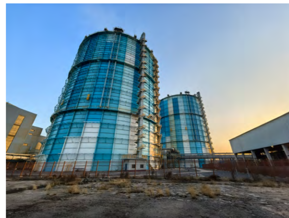
动供总厂高炉煤气联络管道扩径改造，实现高炉煤气近零放散
