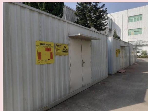
危险废弃物暂存区
