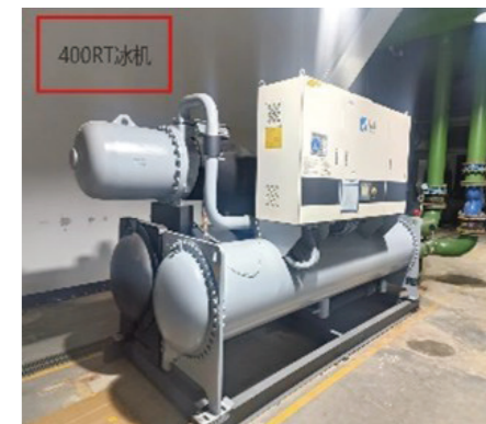
1 楼暖通机房 400RT 冰机更新
