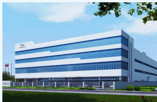
泰国生产基地（建设中）
