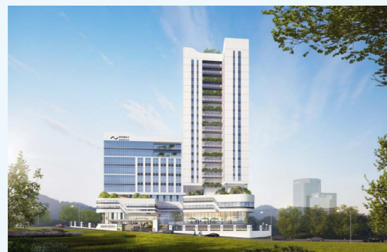
深圳产业基地（建设中）
