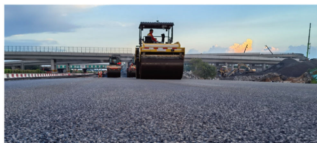
▲ 蔗渣纤维沥青路面技术在钦北改扩建项目应用示范
