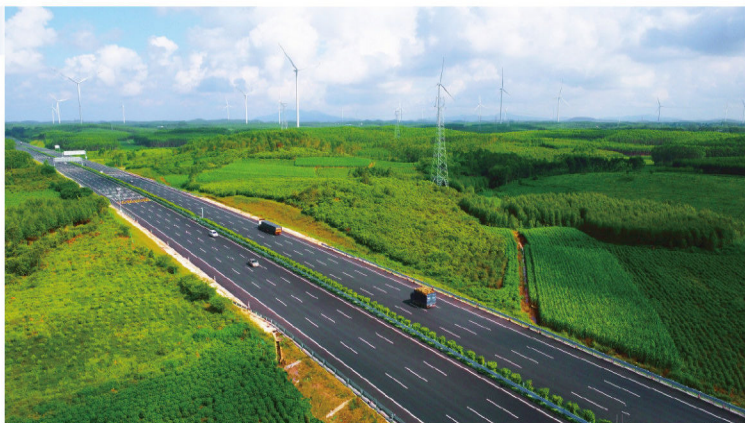
▲ 公司高质量完成广西首条交通运输部“科技示范工程”项目钦北改扩建工程
