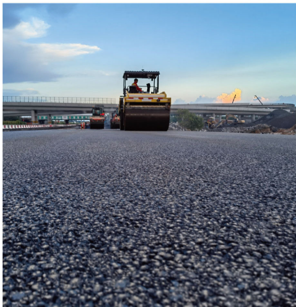
▲ 公司研发蔗渣纤维沥青路面技术在钦北改扩建项目应用示范
