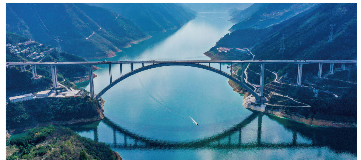
▲ 天峨龙滩特大桥
