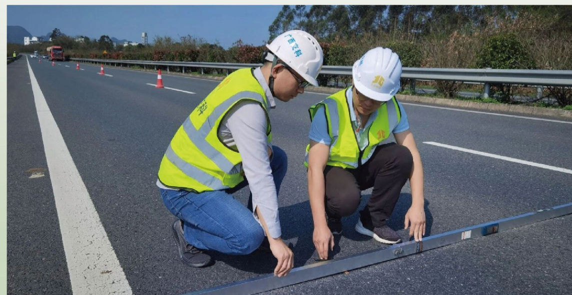
▲ 路面检测现场
