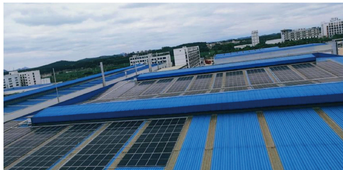
▲ 新材料公司安装屋顶光伏
