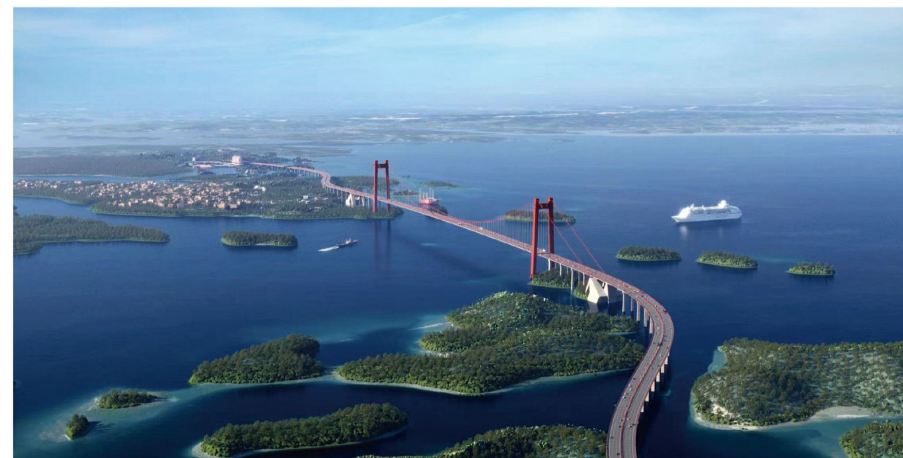
▲ 国道G228丹东至东兴广西滨海公路龙门大桥工程海域施工项目全过程环保管控、用海用岛论证
