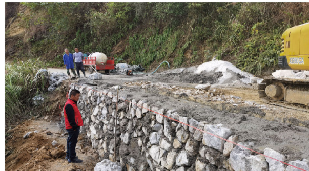
▲ 公司资助道路维修
