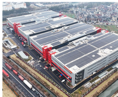
大华智慧物联网产业园屋顶光伏项目
