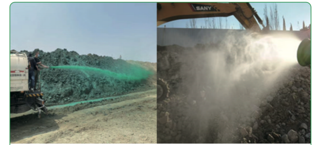
喷洒扬尘抑制剂
