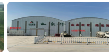
场站绿电供应系统
