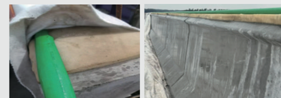
混凝土护栏养护
