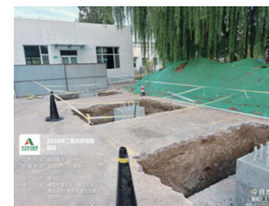
土方精准开挖
