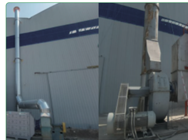
沥青拌合站废气环保净化装置
