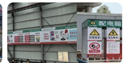
现场施工情况
