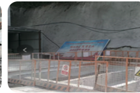
湿喷站三级沉淀池污水利用
