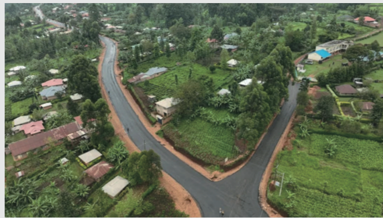
RWC586道路第一里程碑沥青摊铺完成
