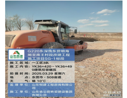
建筑垃圾碾压
