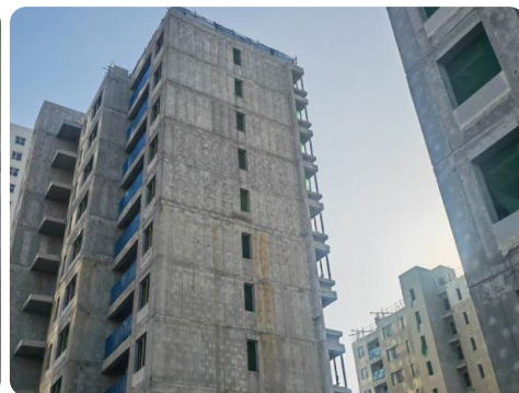
保温墙体一体化安装成型
