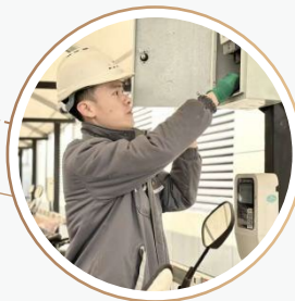
老旧小区电气检查
