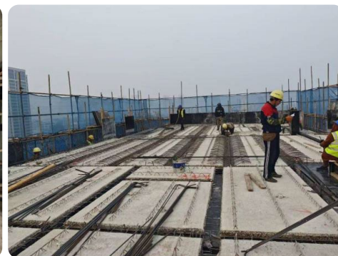
叠合板装配式安装
