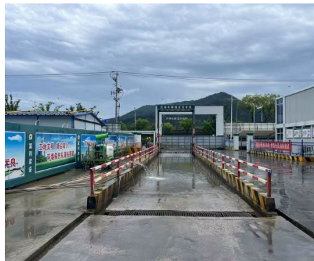
雨水收集用于车辆冲洗、地面降尘
