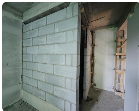
使用蒸压加气砼块，降低能耗
