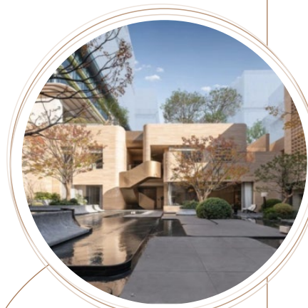
下沉庭院实景图
