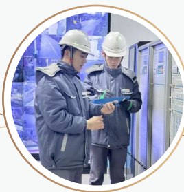
高层建筑消防检查
