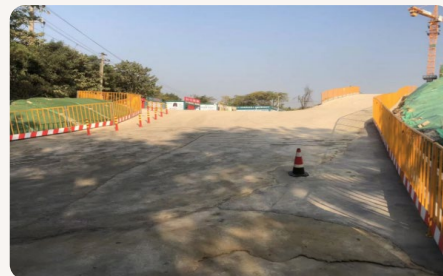
土方回填用于道路硬化
