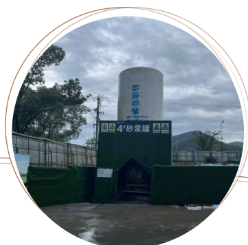
裸土覆盖及散装材料密封储存防止扬尘
