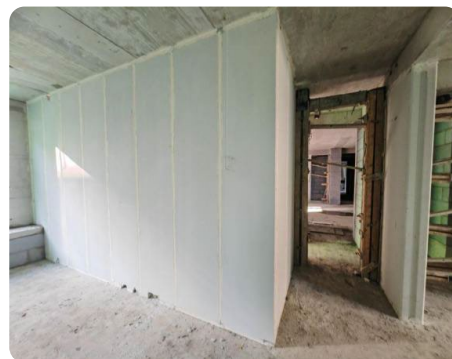
使用预制构件，降低能耗
