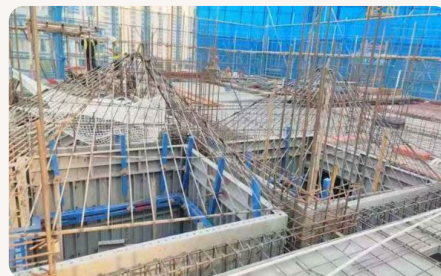
用废旧钢筋制作洞口防护罩
