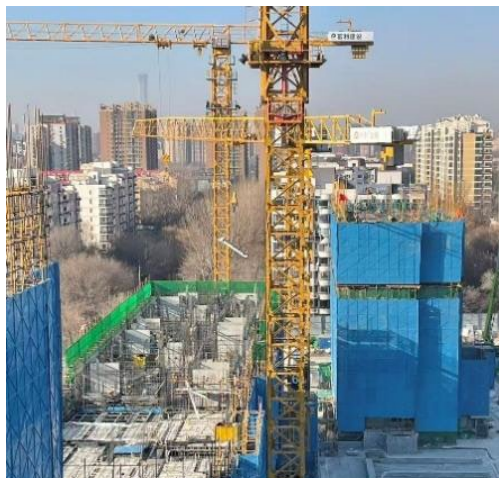
预制构件吊装施工
