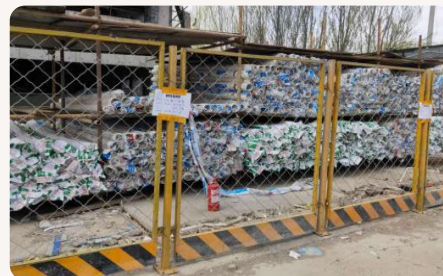
废旧钢材、塑料管处理使用
