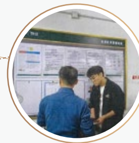
电梯机房安全检查
