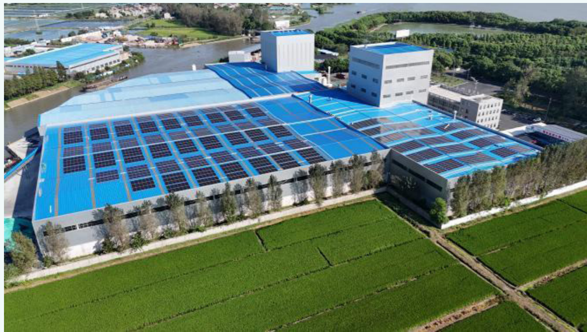
光伏改造、智能加工
