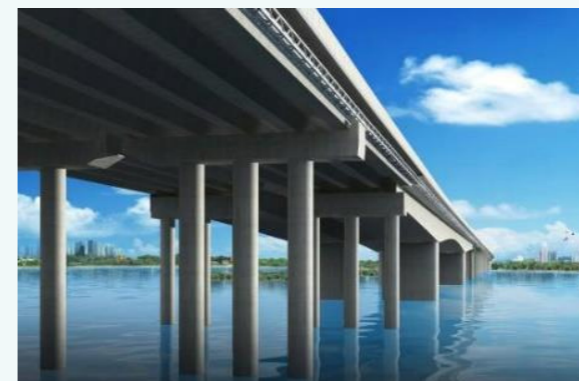
桥面收集系统
