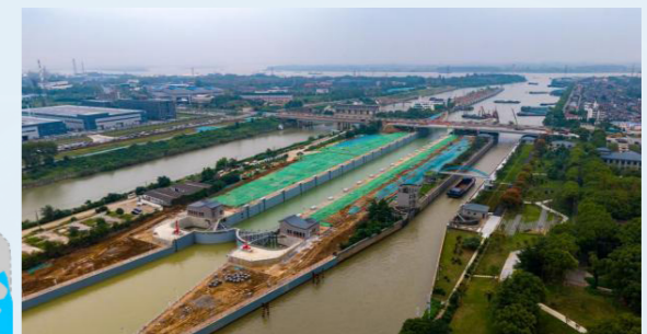
谏壁船闸建成交工实景图
