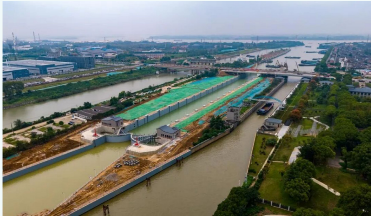
世界内河最大单级船闸实现智慧绿色新突破
