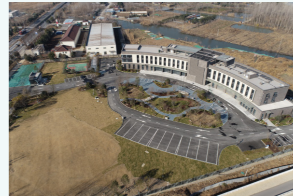
无人机低空遥感监测下的仙新管养中心
