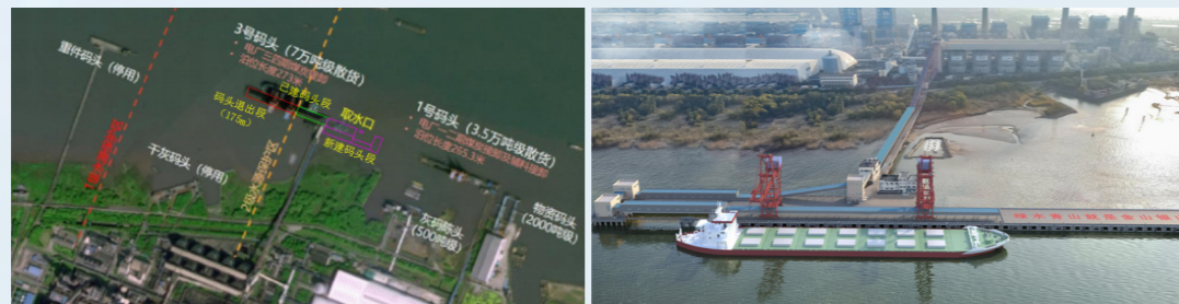
无锡（江阴）港石利港区利港电厂 3 号码头绿色改建项目
