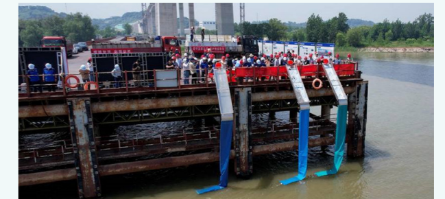
南京仙新路过江通道工程水生生态补偿增殖放流现场
