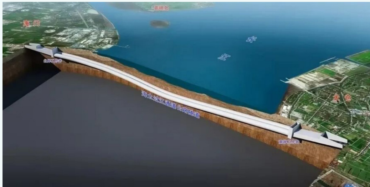
海太长江隧道（公路部分）
