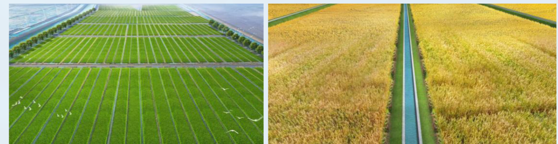
东台市国家盐碱地综合利用试点项目
