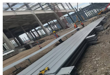
屋面底板现场生产
