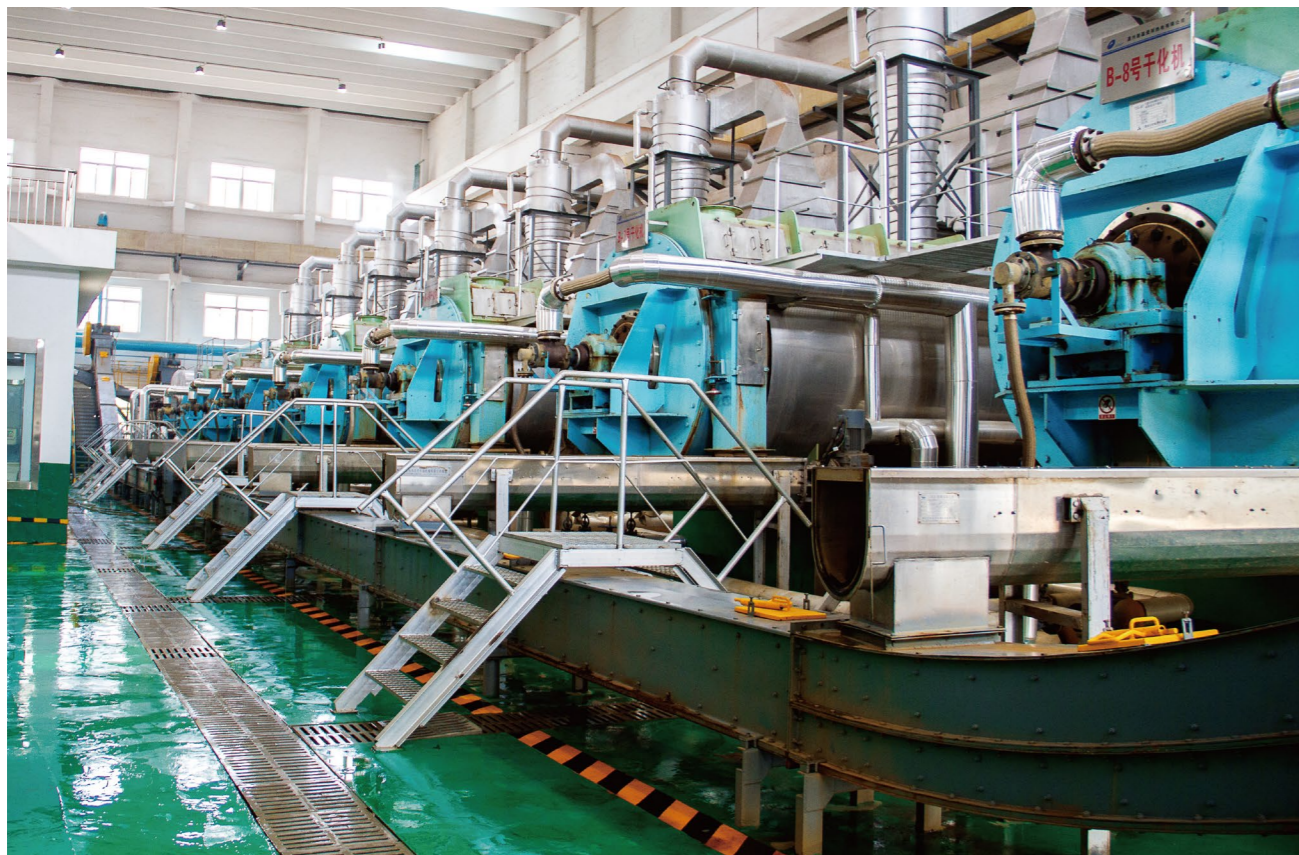
污泥无害化与资源化处置车间
