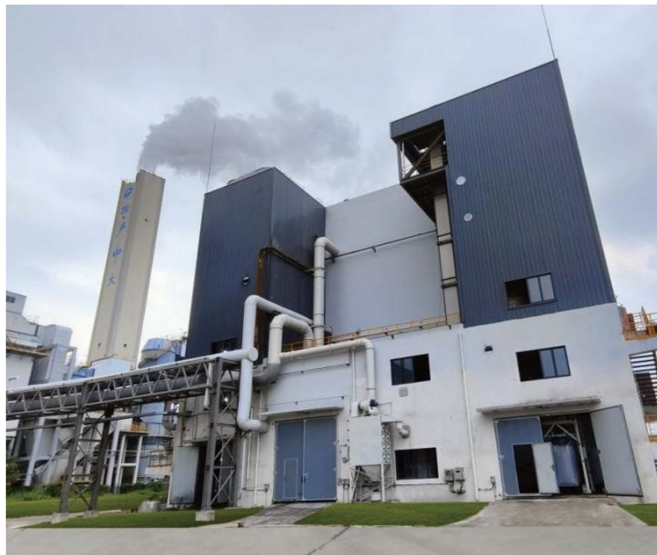
废旧橡胶高值转化与低碳高效利用项目
