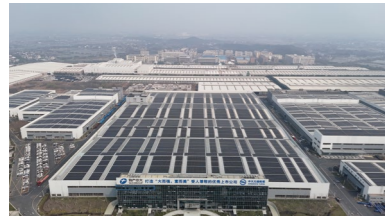
德清线缆光储充一体化综合能源服务示范项目
