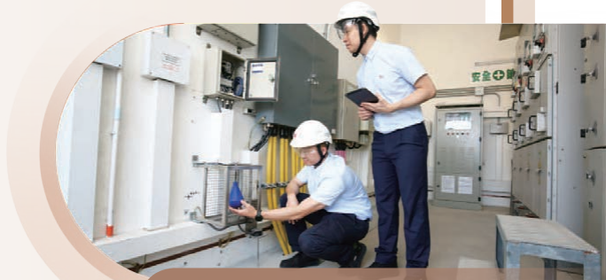
為變電站加強防洪措施
