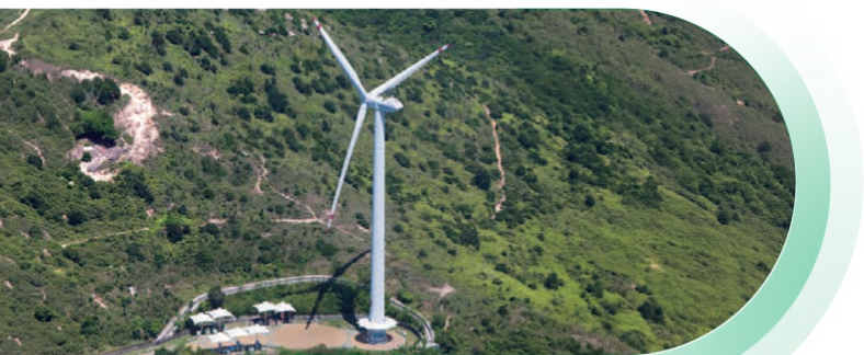
南丫風采發電站
