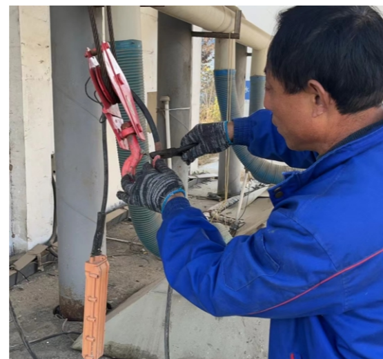
巨野新达隐患整改现场
