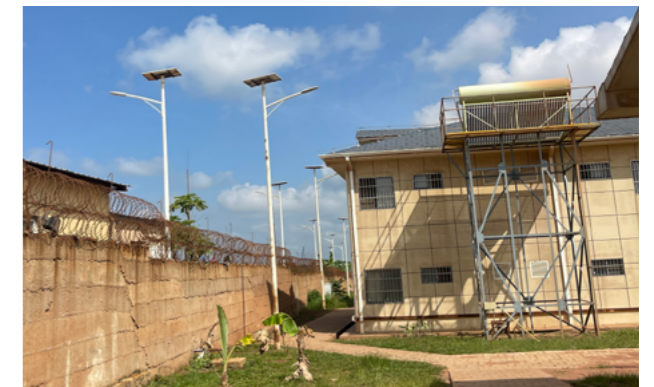
刚果腾远二期宿舍安装太阳能热水器和太阳能路灯
