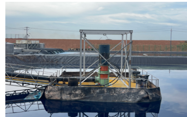
刚果腾远更换富铜液循环池提升泵
