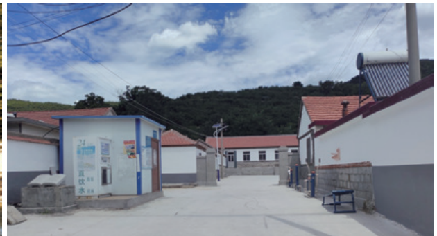
2025 年 6 月大院地面平整硬化
