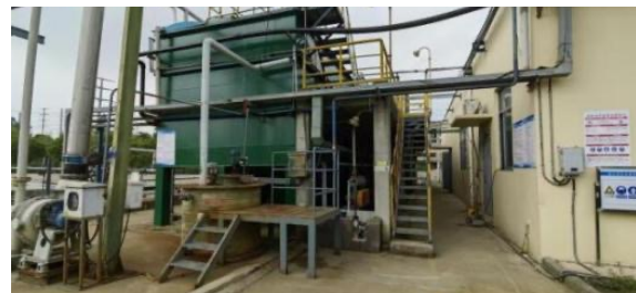
传化合成污水处理站
