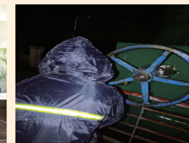
运维人员连夜开展厂区外热网阀门巡检与维护，及时消除隐患
