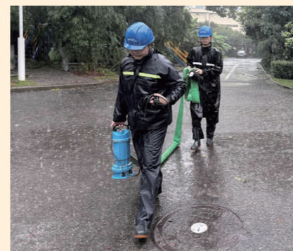
台风期间工作人员顶风冒雨开展防汛排涝工作，提前布置抽排设备
