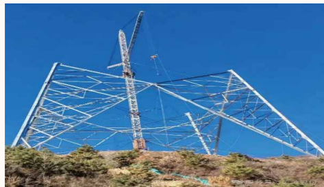
大同-天津南1000千伏特高压交流工程线路工程
