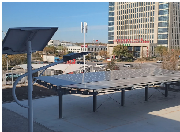
子公司泵业集团建设光伏车棚，太阳能电力用于厂区生产和充电桩使用
