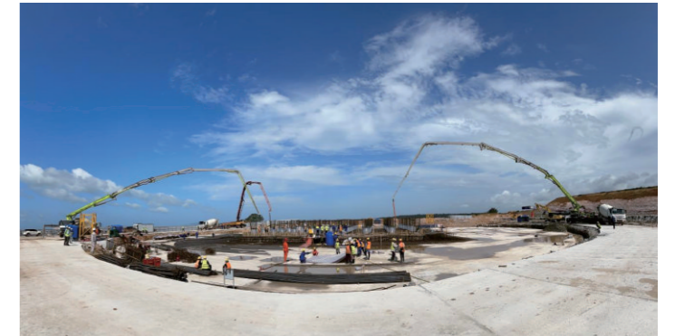
柬埔寨公司发电厂项目现场
