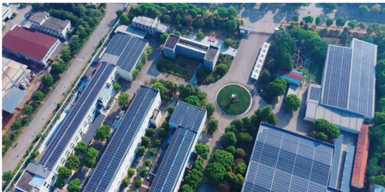
恒达新材生产基地楼顶覆盖光伏板
