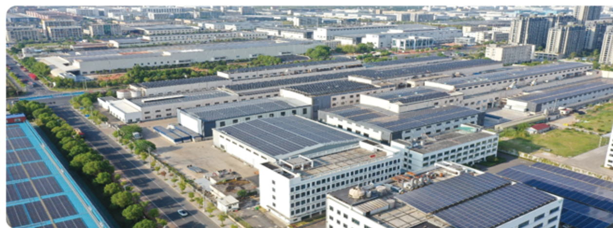
恒川新材（一期）生产基地楼顶覆盖光伏板
