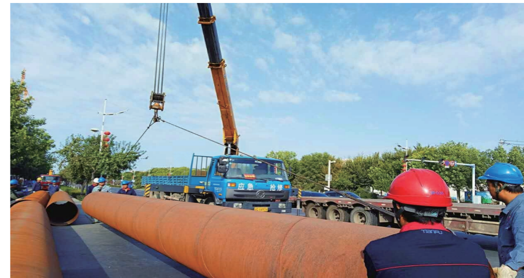
老旧小区供热管网改造
