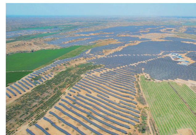
2025年8月，航拍于中新建石玛兵地融合5GW光伏基地一期
