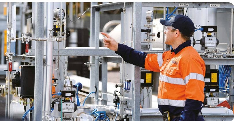
AGN的Hydrogen Park South Australia示範項目以電解方式生產可再生氫能，並將其混入當地配氣網絡。
