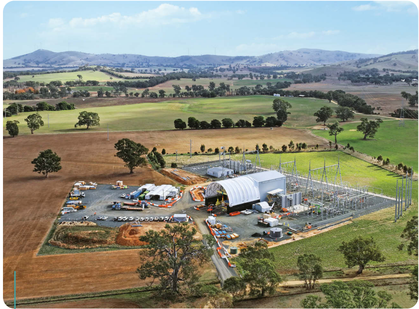
VPN 旗下的工程、採購及建造業務部門 Beon Energy Solutions 於 Ararat 終端站建設全澳洲最大的同步調相機，協助穩定電網，並促使維多利亞省西部高達 600 兆瓦的新增可再生能源順利併入電網。
