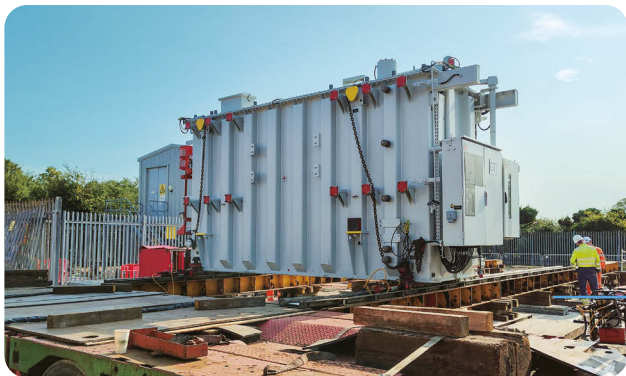
一台重達9萬7,000公斤的Kolektor 132/33kV電網變壓器運抵英格蘭劍橋郡的Burwell Grid。該設備屬一項價值590萬英鎊的容量提升計劃下，需交付的兩台新變壓器中的首台。
