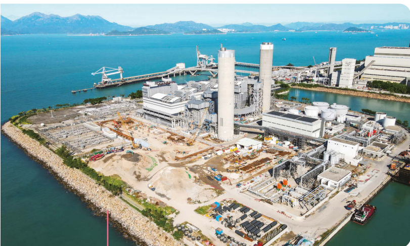
南丫發電廠 L13 燃氣發電機組的鳥瞰圖。
