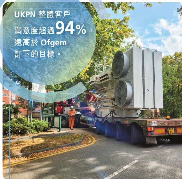
UKPN 於 Central Welwyn 主工地進行更換及升級工程期間，一台 47 噸變壓器在施工人員引導下精準就位。
