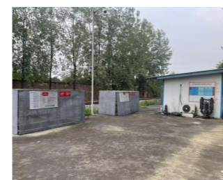
图注：东汽污水处理站
