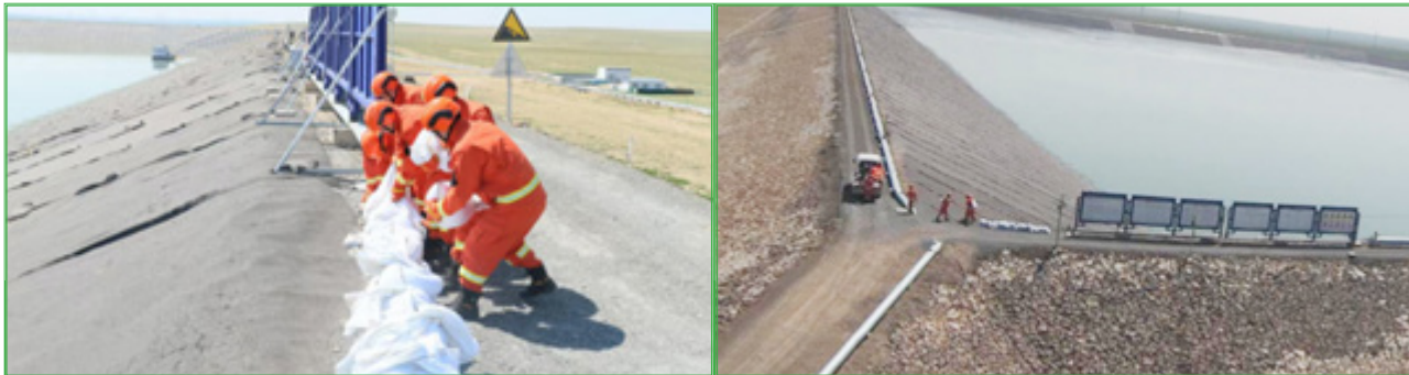
银漫矿业尾矿库专项、现场处置应急演练
