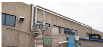
车间粉尘滤筒（布袋除尘器）收集
