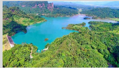
凡口矿尾矿库 3#库区
