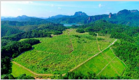
凡口矿尾矿库 2#库区
