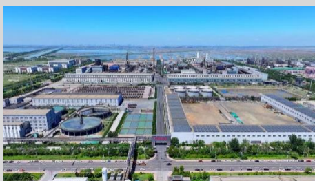
中金铜业光伏电站
