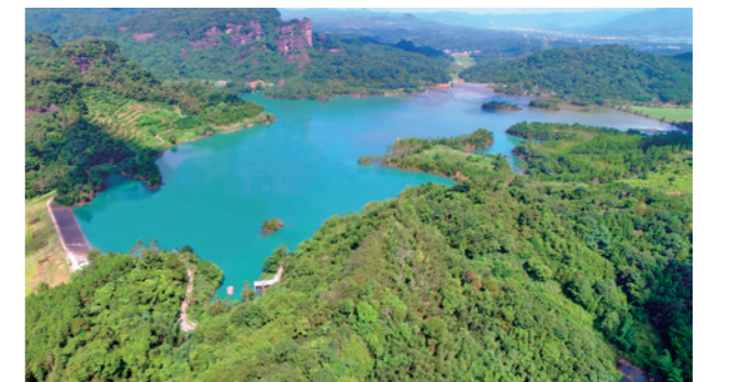
凡口矿尾矿库3#库区
