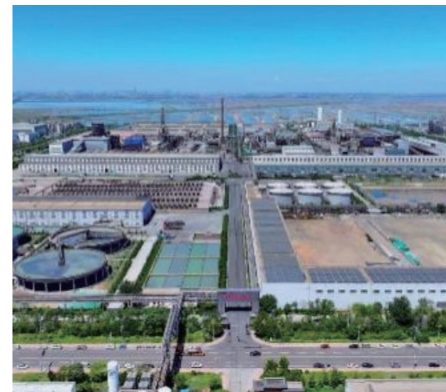
中金铜业光伏电站
