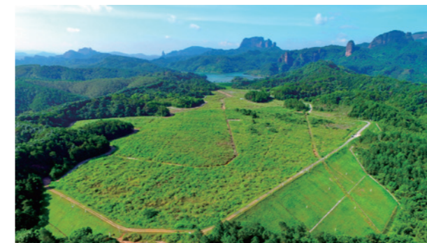
凡口矿尾矿库2#库区
