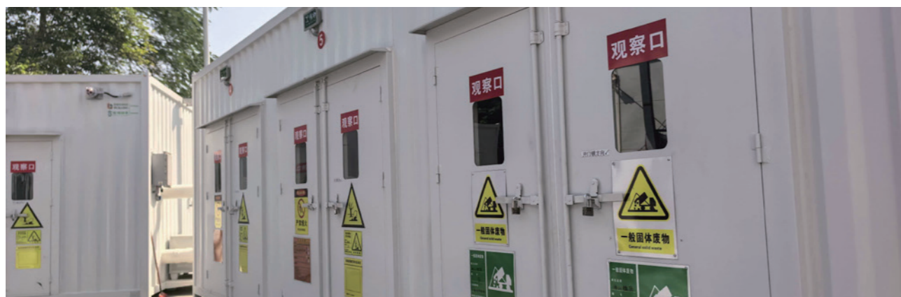
一体式固体废物贮存间
