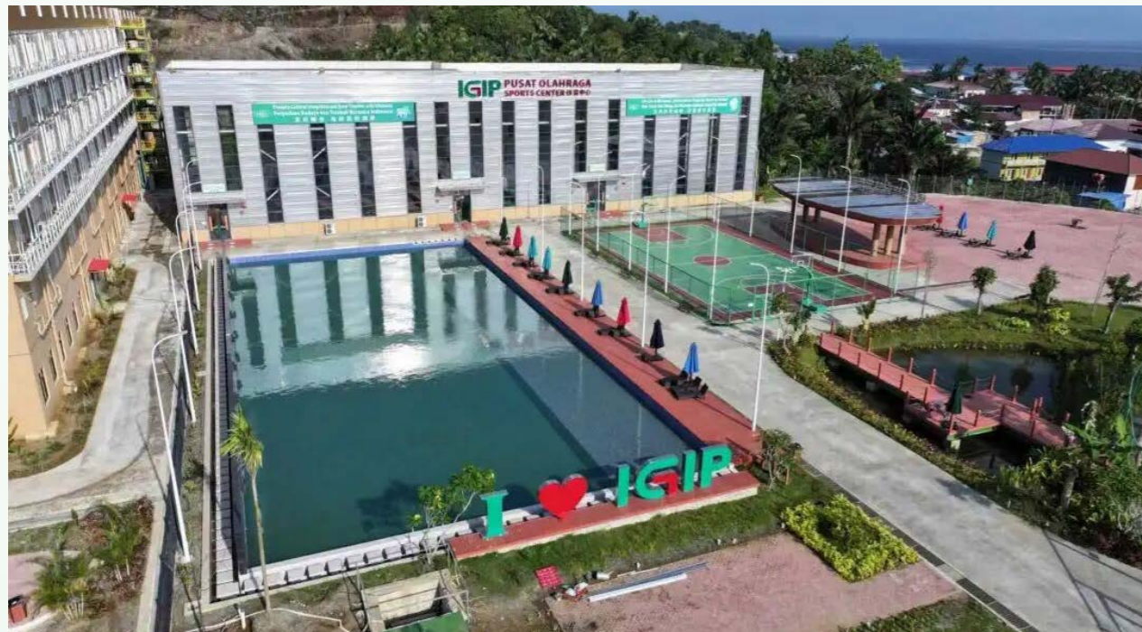
▲ IGIP 园区建成社区体育馆
