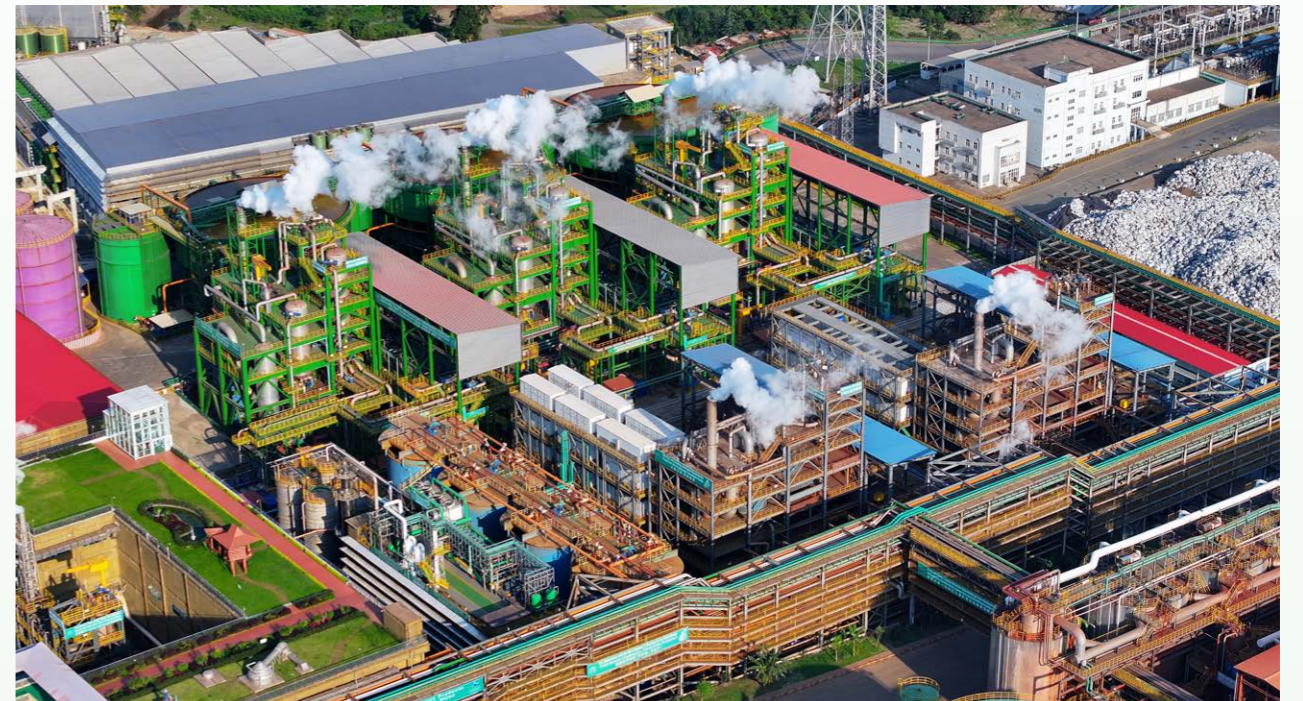
▲ 青美邦园区 15 万吨 / 年高压酸浸镍产能建成投产
