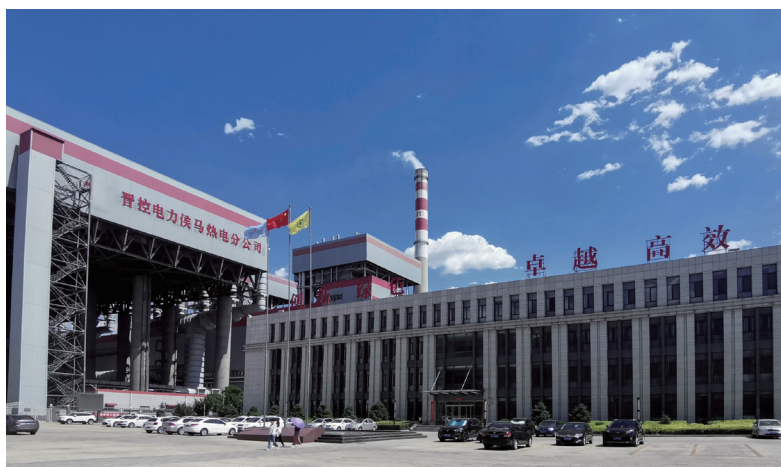
▲ 晋控电力侯马热电分公司
