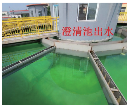
▲ 中水改造项目
