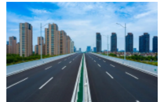
净味高粘改性沥青 减少沥青摊铺过程中有害烟气影响
