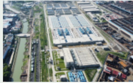
上海竹园污水处理厂四期工程
