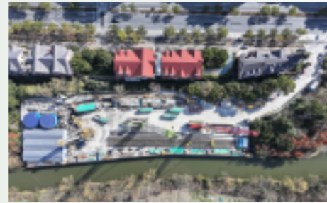
合流污水一期复线工程
