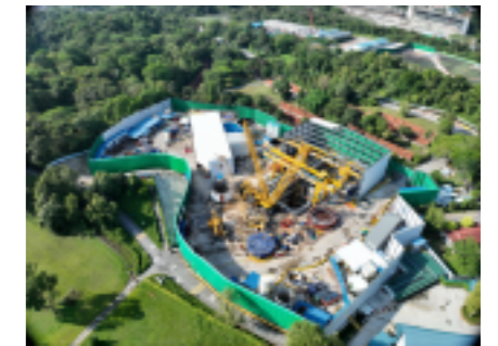
新加坡地铁跨岛线二期CR202项目
