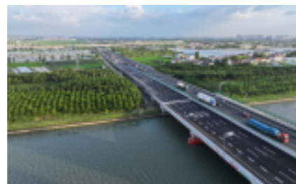
G15沈海高速嘉浏段新浏河大桥
