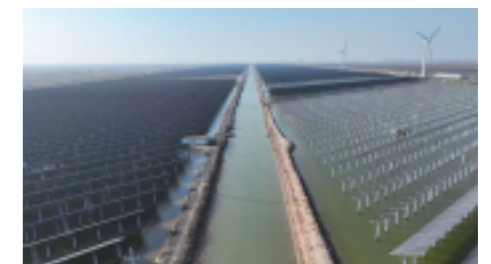
江苏盐城420MW渔光互补光伏发电项目
