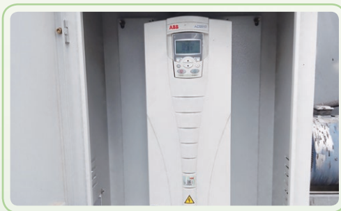
廈門星河COCO Park完成排油煙風機變頻運行改造
