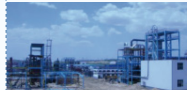
10万吨/年聚氯乙烯项目建设期 厂区一角
