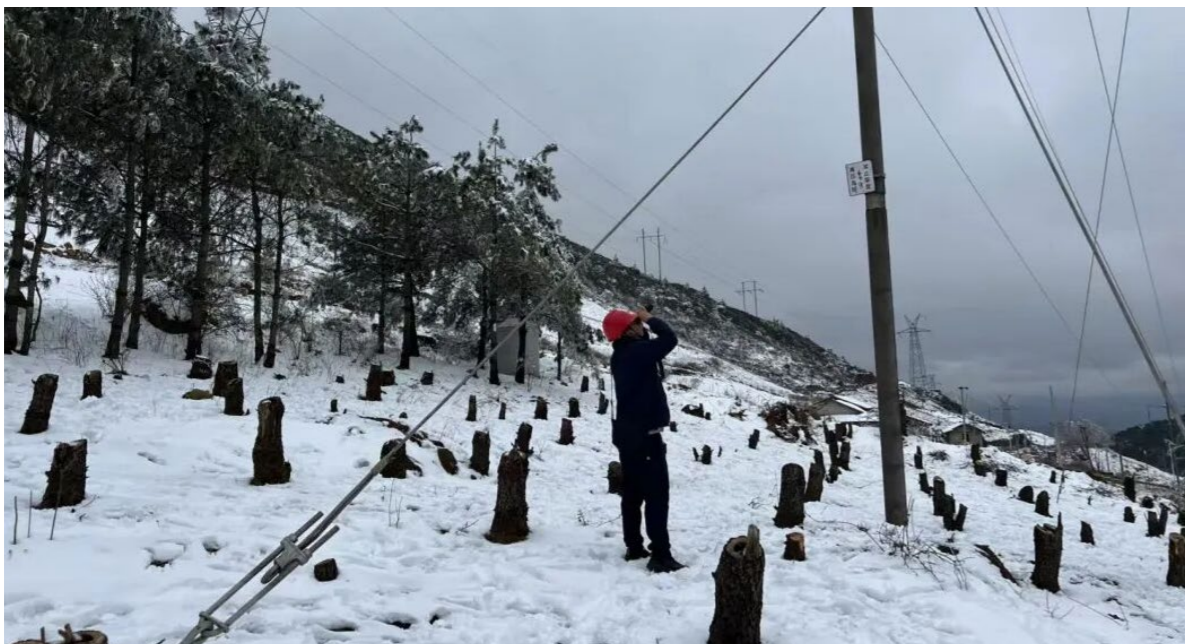
用电检查现场
