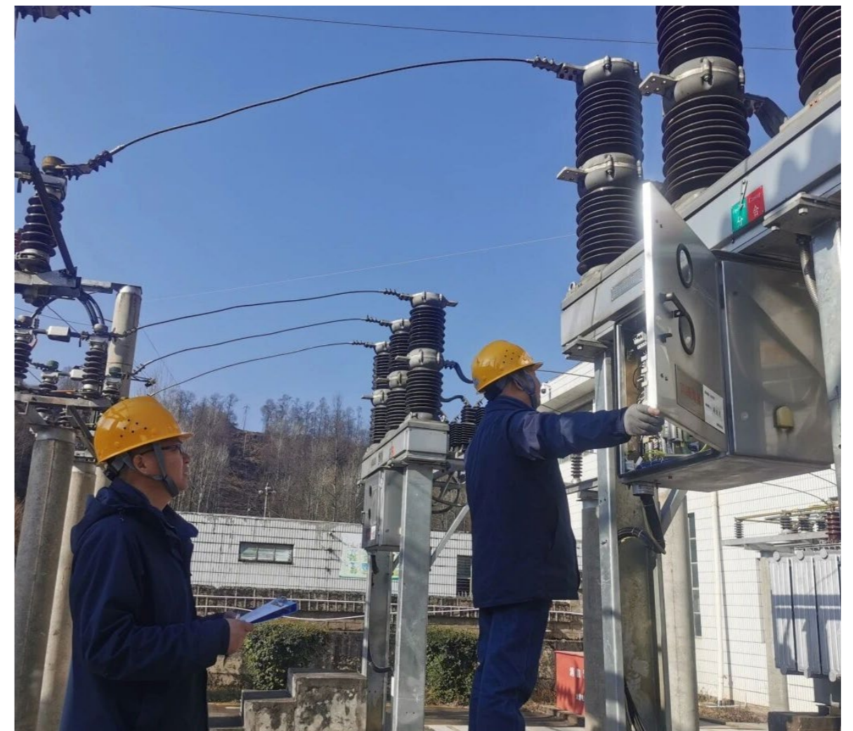
用电检查现场
