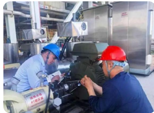
设备维护部对增压泵进行检查
