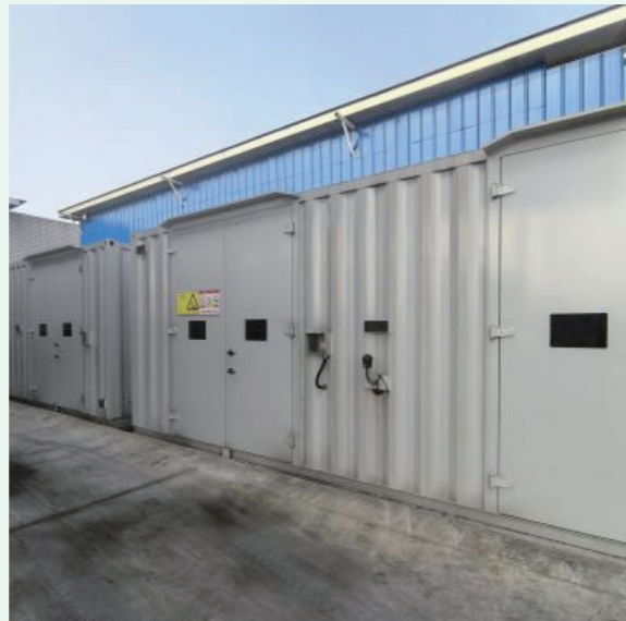
改造后危险废物贮存场
