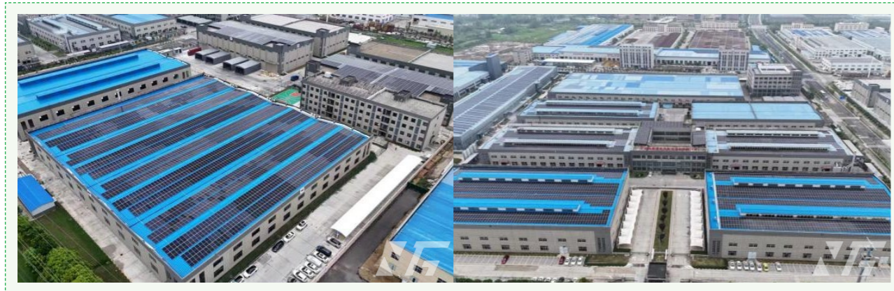
厂区屋顶光伏
