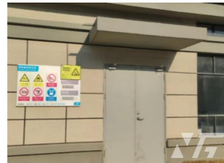
危险废弃物仓库
