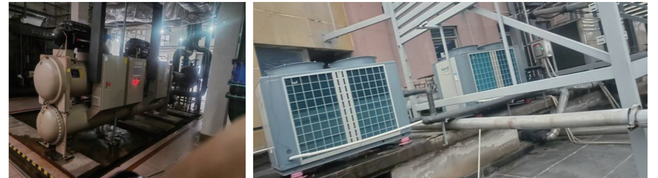
酒店采用磁悬浮空调机组和空气热泵等绿色能源转换设备，实现能耗降低
