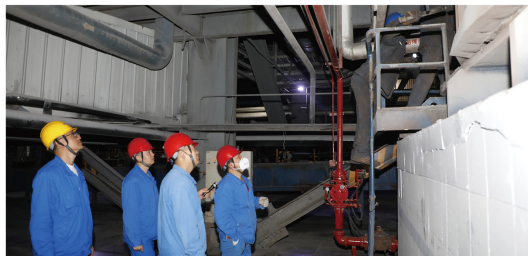
上都发电厂煤电机组生物质掺烧试验成功
