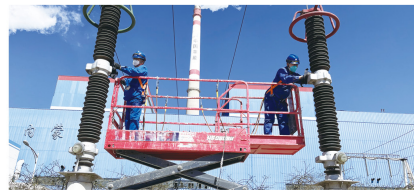
丰泰公司检修人员清扫 2 号发变组避雷器
