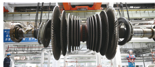
达拉特发电厂 8 号机组 D+ 级检修现场
