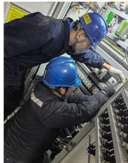
运维人员开展风机巡检及故障抢修工作
